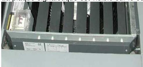
Sur cette plaque sont indiquées le modèle et le numéro de série, l'alimentation électrique (tension, nombre de phase, et fréquence), la puissance absorbée, ainsi que l'intensité absorbée **OA** (courant nominal), **FLA** (courant absorbé maximum), et **LRA** (intensité rotor bloqué) comme indiqué en figure 4.
