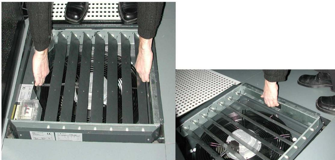
Pour garantir un fonctionnement optimal de la dalle « **ACTIVE FLOOR** », il est conseillé de laisser une hauteur minimale sous la dalle, de 150 mm.
