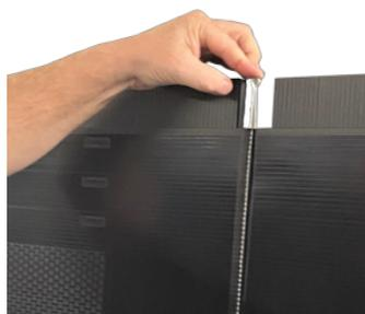
8. En fin d'opération, en montant sur un équipement sécurisé (PIRL,...), introduire la dernière épingle en accouplement des deux ½ section supérieures
