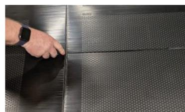
3. Découper les 3 côtés déplié avec l'aide d'un outil tranchant de type cutter à lame rétractable
