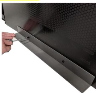
1. Non intrusive sur le sol ou le plancher, la platine-équerre est simplement fixée dans la base de la baie occultante par des vis auto-perçantes fournies dans le kit
