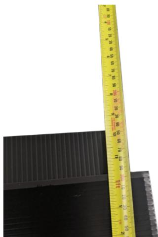
1. Mesurer la hauteur manquante au-dessus de la baie occultante standard (2130 mm)
