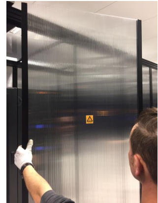
Si possible maintenez les éléments déposés afin d'éviter leur chute en salle (2 ème opérateur)
