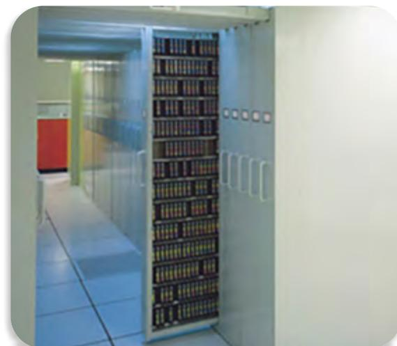
Armoires de sécurité pour stockage de masse avec un silo ouvert
