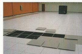
En cas de découpe pour passage de fluides ou chemins de câbles, il est conseillé de découper le contour et d'éviter au maximum le retrait de matière.
