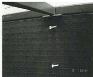
5- Pour placer verticalement les plaques, aligner une pré-découpe verticale avec la tige d'un vérin de faux plancher, puis enfoncer les oblongs pré-découpés et introduisez un rilsan® par ces 2 trous en incluant la tige de vérin
