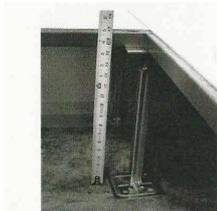
1- Mesure de l'espace vertical entre la sous face des dalles de faux plancher et la surface de la dalle béton = hauteur du plénum
