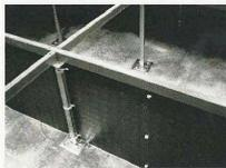
NB : Pour les plénum de hauteur > 600 mm , des sections de plaques additionnelles peuvent être ajoutée verticalement comme indiqué au § 3 ci dessus, Cette section supplémentaire devant excéder d'au moins une pré-découpe le complément requis pour permettre l'entouillage et donc la fixation par rivets sur la plaque principale
