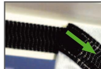
La bande auto-agrippante collée sur la surface d'appui (cornière) et cousue sur le rideau permet un dépôt / repositionnement / remplacement aisé des rideaux lorsque la taille des baies à couvrir varie dans la travée à traiter.
