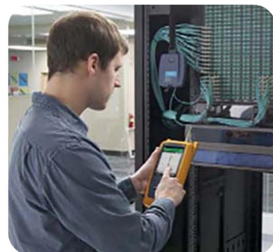
Exemple de test au réflectomètre sur liaison de fibre optique
