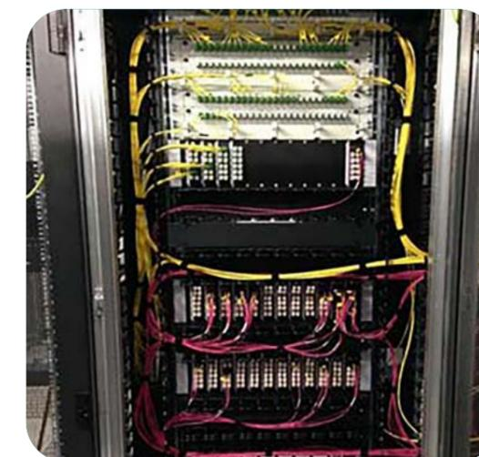
Exemple d'installation avec fibre monomode OS2 en partie haute et fibre multimode OM4 en partie basse
